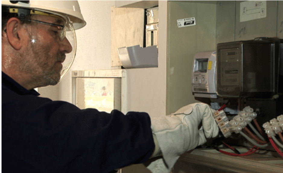
Un operario instala uno de los nuevos contadores. | E
